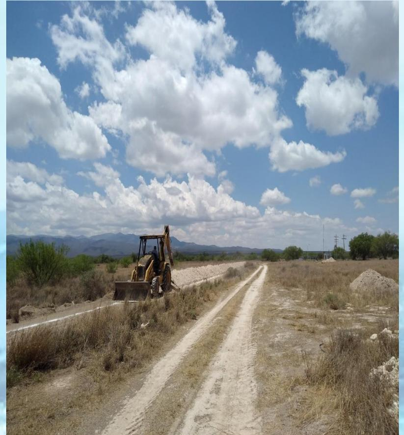
**COLOCACION DE BYPASS PARA REDIRIGIR EL FLUJO ENTRE LAS LÍNEAS DE CONDUCCIÓN, EN AMBOS ACUEDUCTOS; EN ZONAS CON VALLES Y CRESTAS, DONDE EL FENÓMENO DE AIREACIÓN EN EL INTERIOR DE LA TUBERÍA OBSTRUYE PARCIALMENTE EL FLUJO O DISMINUYE LA VELOCIDAD DE CONDUCCIÓN EN ACUEDUCTOS VANEGAS CEDRAL CON INTENCION DE LA CORRECCIONES A PERDIDAS.**
