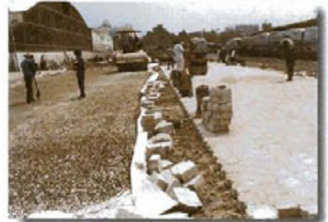
Pavimentos de Adoquin
