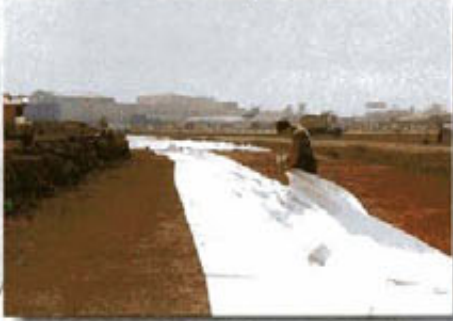
Pavimentos de Aeropuertos
