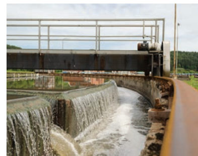
Figura 3.6. Planta de tratamiento de aguas residuales.
