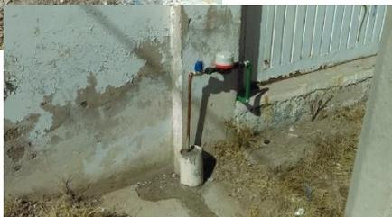
5. Durante el presente ejercicio se ejecutó el cambio de **31** tomas de agua potable derivado de su término de vida útil, siendo los motivos más comunes la degradación del material que conforma el ramal de toma, presentando perforaciones, así como el taponamiento en la misma.
