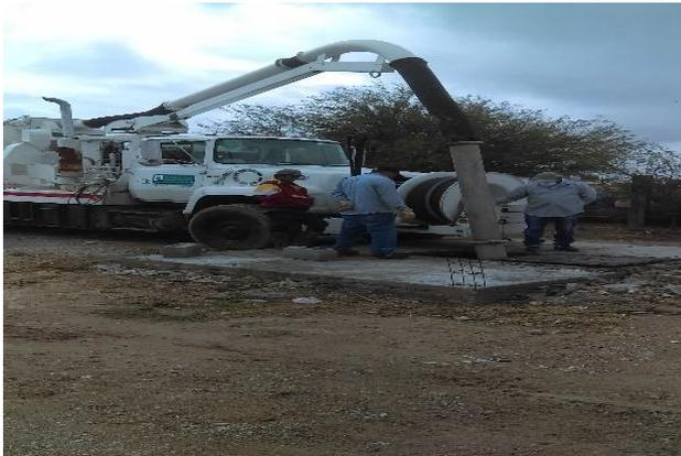
Se realizaron 8172 ml. De limpieza con equipo de desazolve en redes de alcantarillado.
