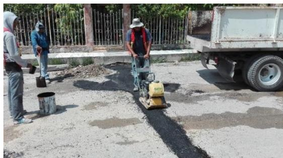
7. Reposición de pavimento “baches” en **85** domicilios diferentes, siendo en 10 de estos a base de concreto hidráulico y en 75 a base de carpeta asfáltica.
