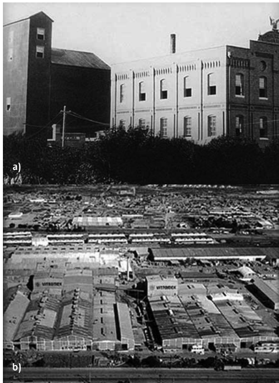
(a y b) La expansión de la inversión privada impulsó el crecimiento de la industria manufacturera. En menos de 20 años el auge industrial se evidenció.
