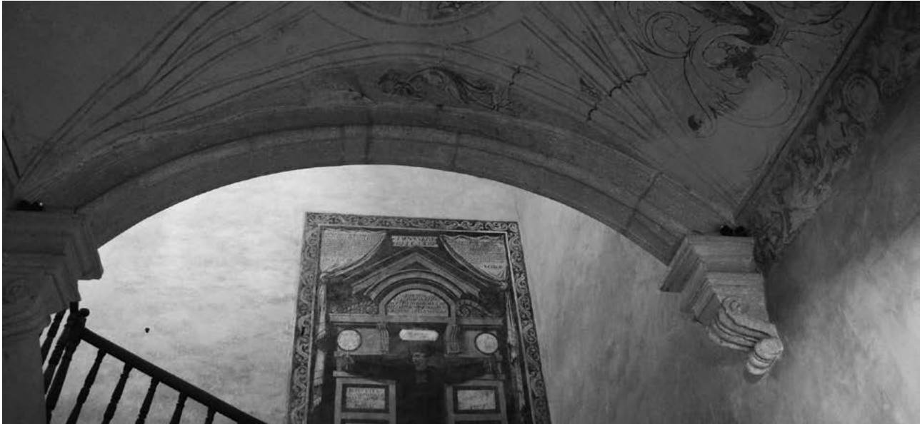
Figura 41. Detalle en acceso al cubo de escalera (Q). Fotografía de la autora.
