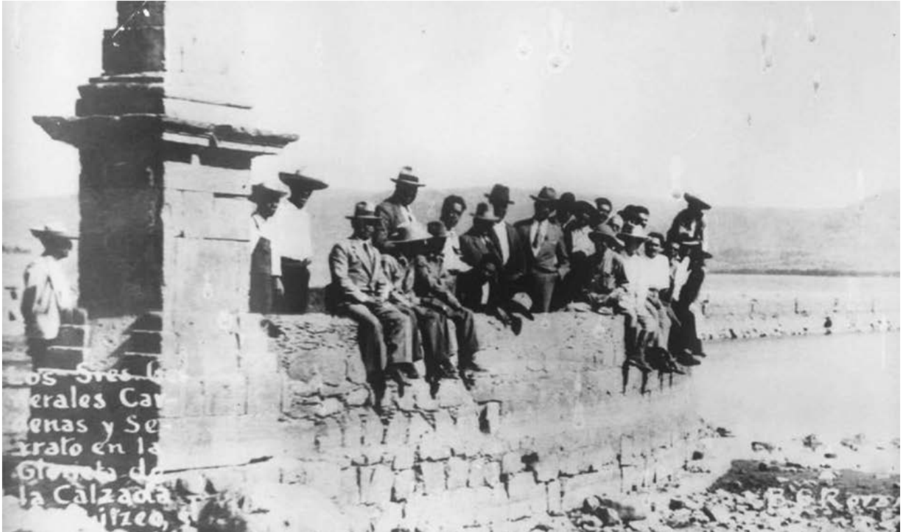
Figuras 1 y 2. Vistas de la calzada. Fotografías cortesía de Lorenzo Reyna.
