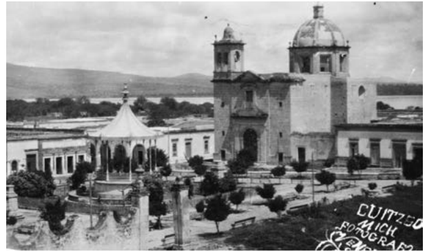
Figura 10. Vista del atrio. Fotografía cortesía de Leonardo Ramos.
