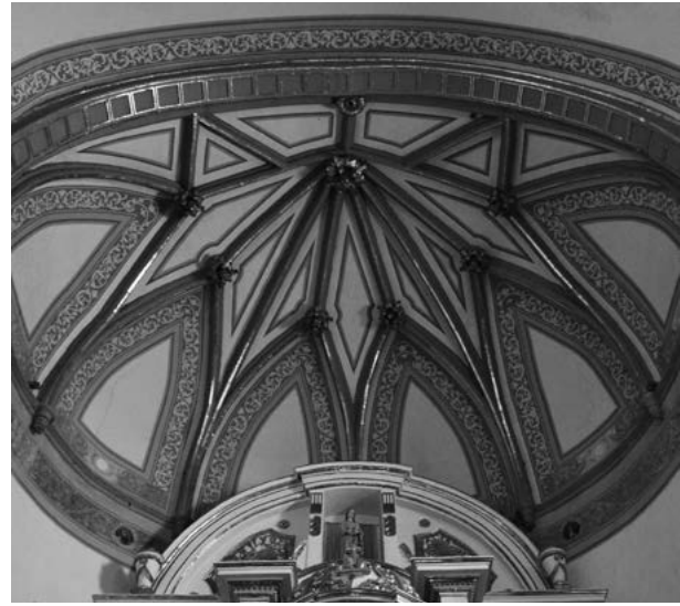
Figura 28. Detalle del sistema de cubierta del presbiterio (E). Fotografía de la autora.
