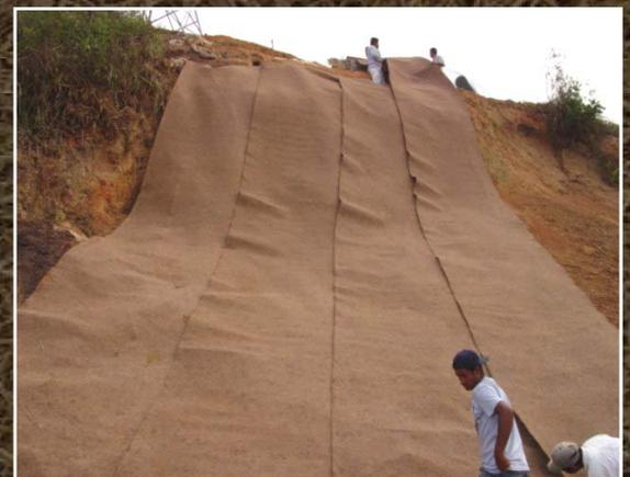
BIOTEXX® Coco se suministra en rollos que se traslapan para dar continuidad a la protección, y sus extremos se atrapan en trincheras de anclaje. Mediante anclas metálicas, se sujeta la malla a la superficie del talud o corte.
