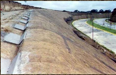
1. Instalación de BIOTEXX® Coco reforzada, para contención de caídos y protección contra erosión. No se aplicó semilla
