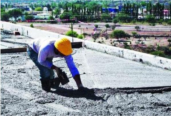
Los entrepisos con viguetas son preferidos por su rapidez de montaje y por su menor peso respecto del hormigón macizo. Además, aportan aislación térmica adicional al techo. Sin embargo, un descuido o falta de pericia durante el armado puede originar deformación o dilatación térmica diferencial, así como problemas de cuarteado en el cielo raso aplicado.
