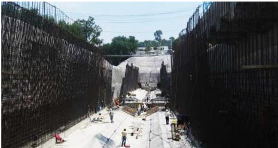
Foto: Canal de salida punto por donde se inicia la excavación del Túnel Emisor Poniente II.
