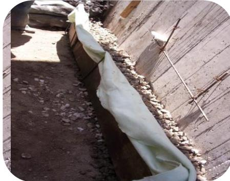
Drenaje de muros de Concreto
