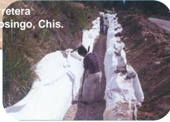
La falta de drenaje es la principal causa de fallas de los pavimentos: con PAVITEX® es posible proteger su estructura, construyendo subdrenes de trinchera en los hombros de las carreteras, usando grava gruesa, mal graduada y libre de finos, envuelta en PAVITEX®. De esta manera se cortan las líneas de flujo, se abate el nivel freático y se mantiene el VRS de base y sub-base, incrementando la vida útil del pavimento.
