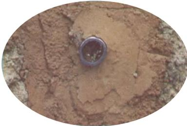
Tubo de un dren de penetración azolvado, por falta de un filtro alrededor de él
