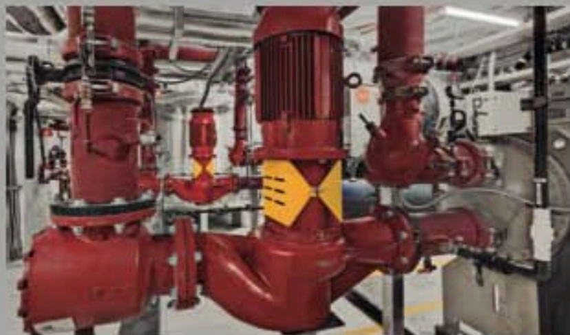
—Las bombas verticales en línea con acoplamiento cerrado EnviroFlo proporcionan calidad y confiabilidad de clase mundial en la circulación de agua de condensador para 18 unidades.
