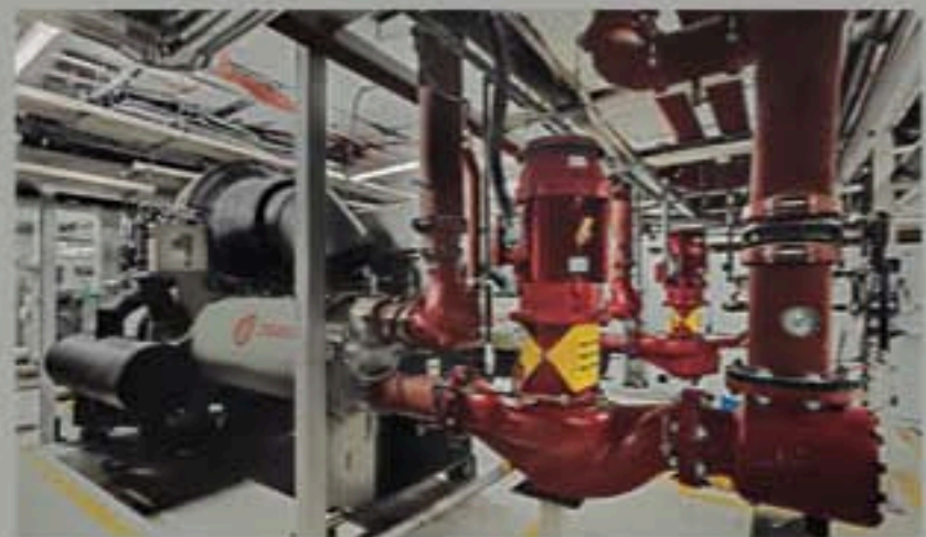
—Las bombas verticales en línea con acoplamiento cerrado EnviroFlo proporcionan calidad y confiabilidad de clase mundial en la circulación de agua de condensador para 18 unidades.
