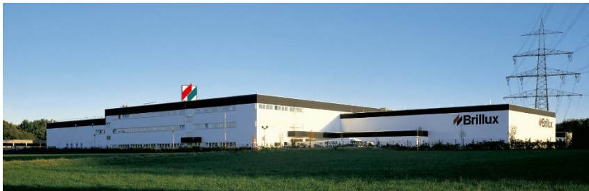
Planta industrial en Unna - Alemania
