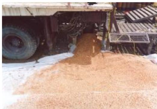
La instalación de la grava debe efectuarse en forma continua, manteniendo un flujo de agua constante desde la superficie, por el espacio anular. Así mismo es conveniente accionar un pistón dentro de las rejillas produciendo flujos alternos que impidan, o resuelvan la formación de puentes o vacíos. La cantidad de grava que ingresa al pozo debe ser permanentemente controlada, tomando en cuenta que se puede prever un volumen 25% mayor que el volumen calculado del espacio anular.
