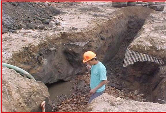
*Cuando se construye sobre suelos arcillosos o en terrenos que han tenido uso agrícola o en zonas bajas sujetas a inundaciones, debido a lo inestable del terreno, es frecuente la necesidad de realizar un mejoramiento previo al terreno, antes de poder construir naves industriales, viviendas, centros comerciales, pavimentos o proyectos similares.*
