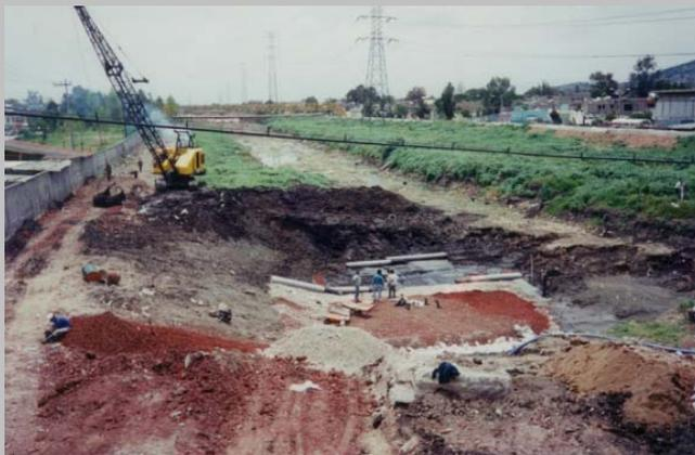
**PROTECCION DE ENTUBAMIENTOS DE CONCRETO CONTRA ASENTAMIENTOS DIFERENCIALES**
