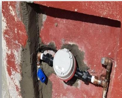
**Sustitución de 415 micromedidores en cuadro y 15 modificaciones con micromedidor.**
