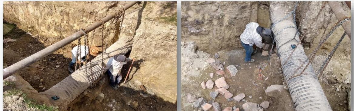
Trabajos de acondicionamiento en la zanja norte de la Planta Tratadora para realizar el taponamiento de las posibles abras que desembocan hacia el humedal artificial.
