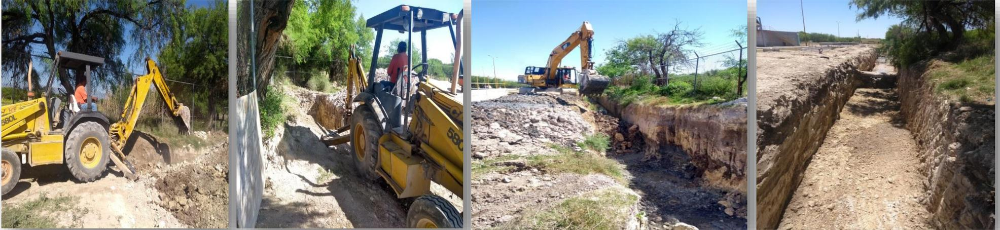
Construcción de muro de mampostería en zanja norte de la PTAR, con el fin de evitar filtraciones de agua hacia el humedal artificial (dimensiones: 3.0 x 0.8 x 4.0 m).
