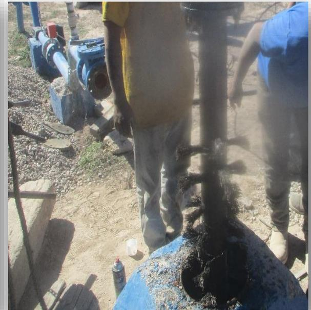
**Rehabilitación a pozos de agua potable (Fabiola, 11, 17 y 25), incluye cepillado, desazolve, reparación de colapso en ADEME y engravado.**
