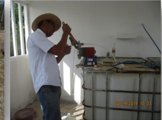
SE REALIZO CAMBIO DE ADAPTADORES KITEC DE LAS CONEXIONES DE LA BOMBA DOSIFICADORA DE CLORO DEL POZO NO. 19.
