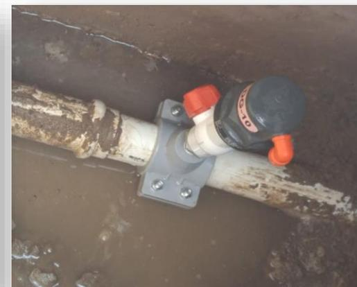
INSTALACIÓN DE VÁLVULAS EXPULSORAS DE AIRE
