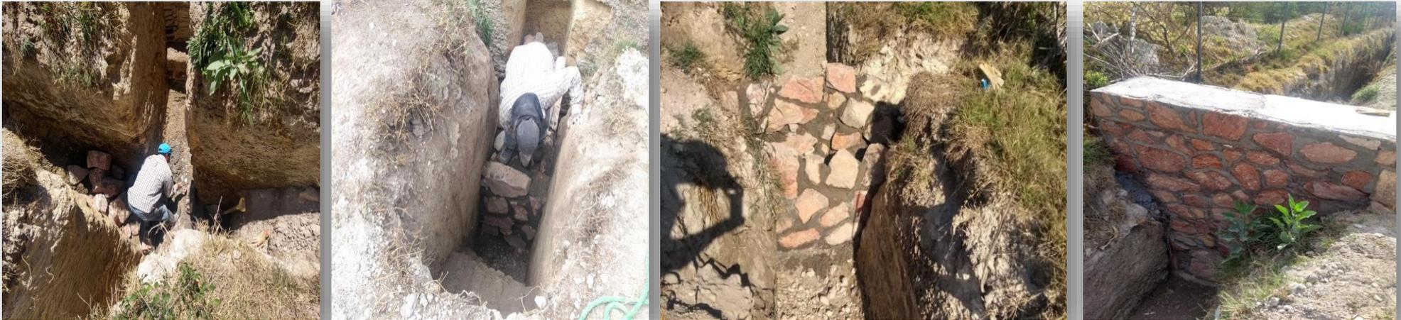
Se construyeron dos atraques de mampostería para soporte de la tubería de entrada a la Planta Tratadora, debido a su exposición por las excavaciones realizadas en la zanja perimetral.
