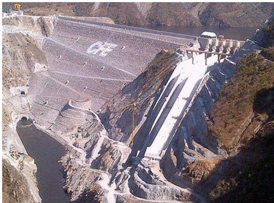
Vista aérea de la cortina y el vertedor de demasías
