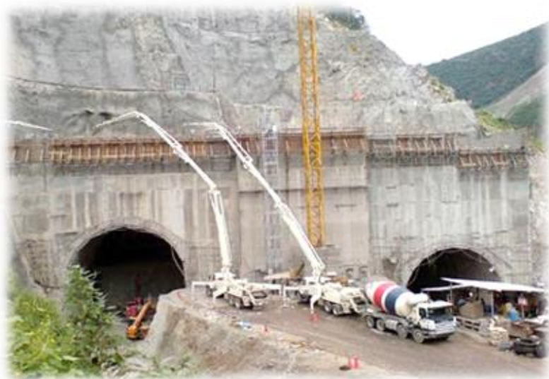
Foto: Durante el bombeo del concreto de la estructura de salida de los túneles
