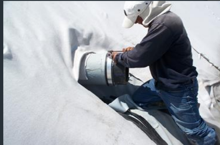
Impermeabilización de la conexión con el tubo de alimentación de agua.
