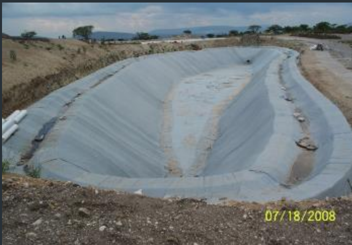
Vista de la trinchera de anclaje
