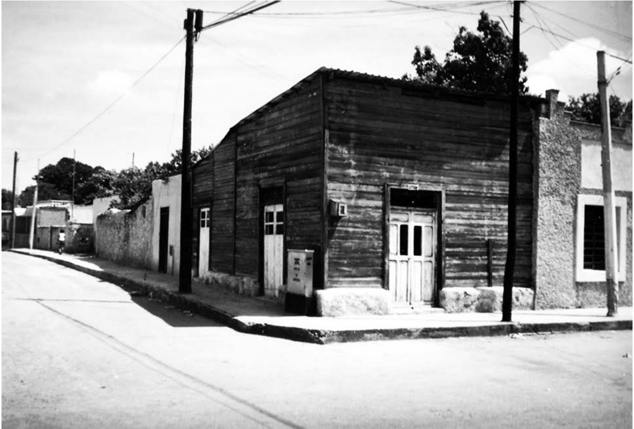
Figura 2. Casa esquinera de madera y cubierta de lámina, ubicada en uno de los suburbios de Mérida, actualmente inexistente. Fotografía de Rubén Vega.
