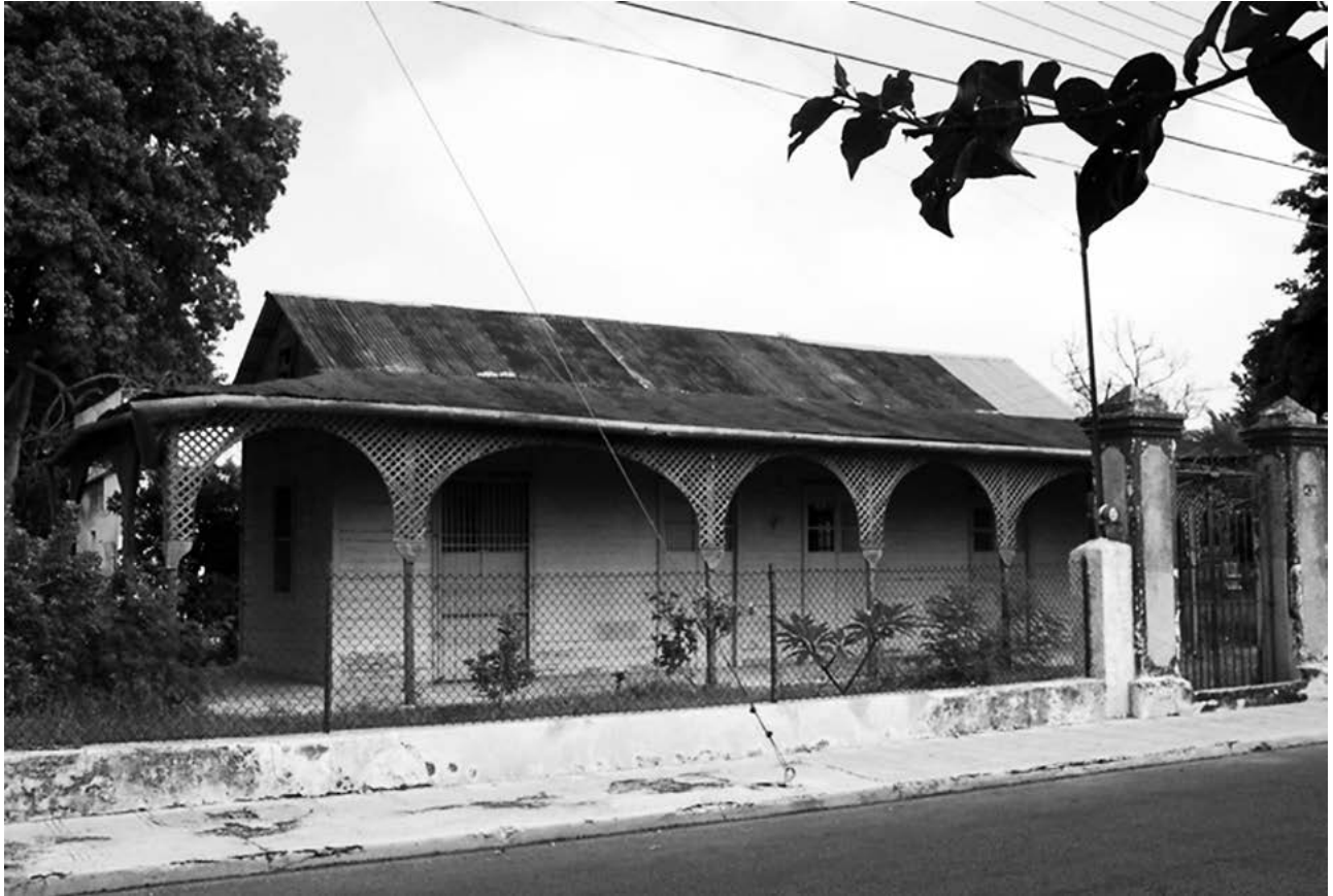
Figura 1. Casa de madera que aún existe en el Paseo de la Reforma, una de las pocas que perviven en la ciudad de Mérida. Fotografía de Rubén Vega.
