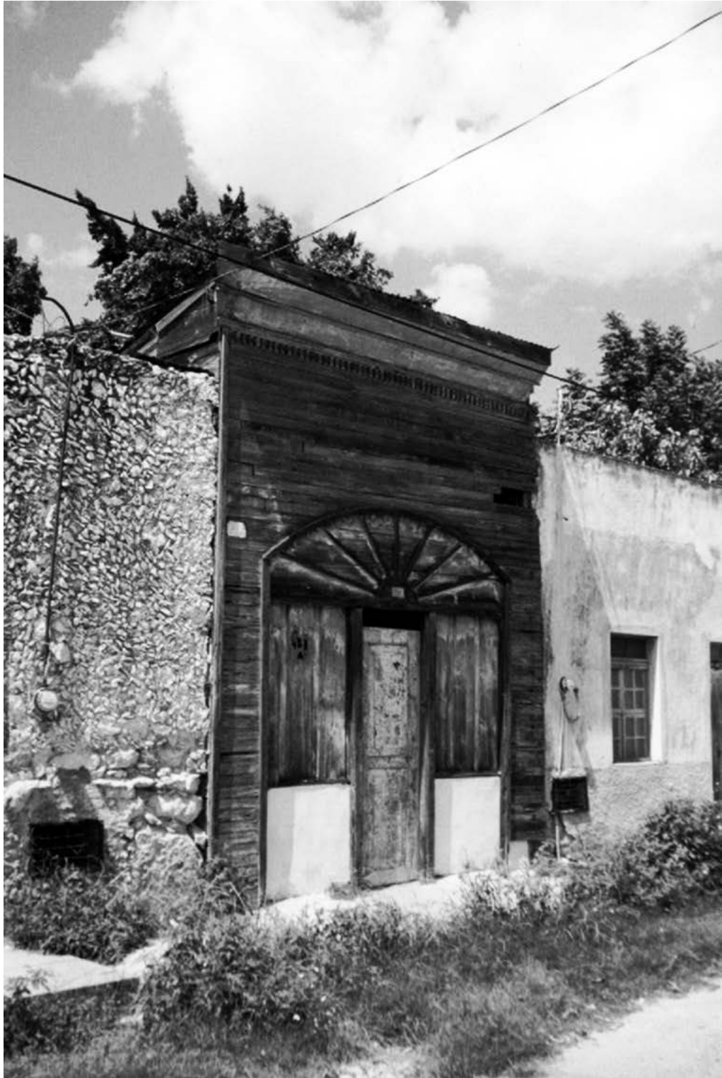
Figura 6. Casa suburbana de madera de escaso frente pero de delicado diseño. Nótese la cornisa de madera, los dentículos, el enmarcamiento con su frontón semicircular con un sol radiante inserto, entre otros aspectos. Actualmente ya no existe. Fotografía de Rubén Vega.
