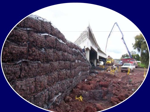
FACHADA DE MUROS DE SUELO ARMADO
