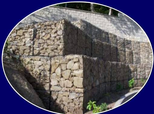
MUROS DE CONTENCIÓN
