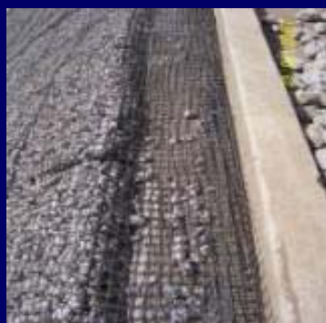
Colchoneta conteniendo grava de 38 mm
