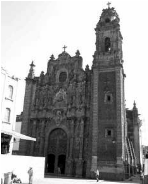
Figura 2. Fachada. Fotografía de Carlos Segura Martínez, noviembre de 2008.
