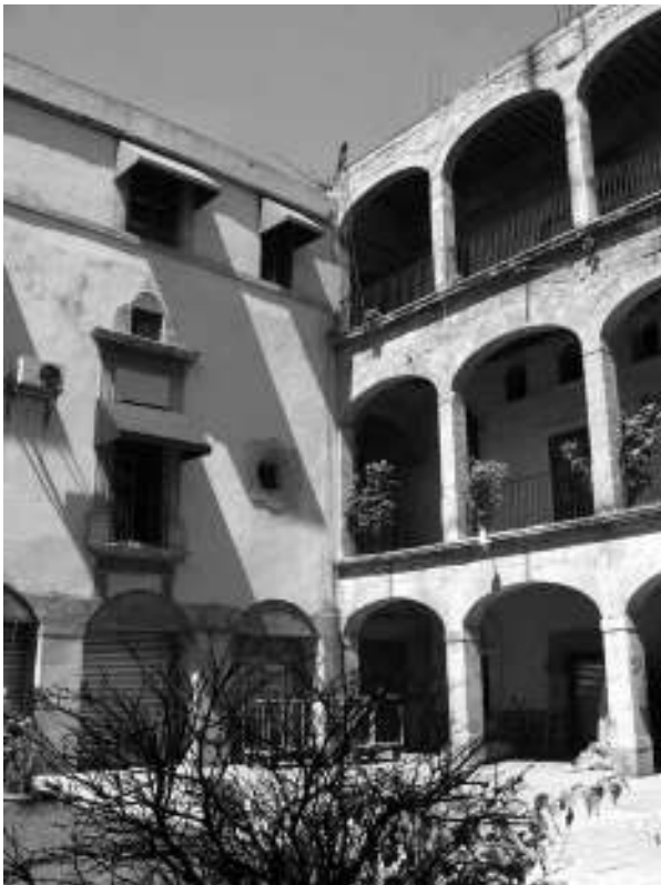
Figura 37. Fachada e interior del inmueble número 10 actualmente. Fotografía de Ethel Herrera Moreno.
