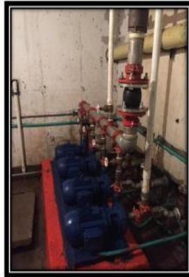
*4. Se realizó en las Líneas de Succión, la instalación de Nipleria en acero inoxidable con válvulas de pie para cada bomba.*
