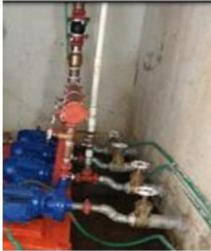
5. Se realizó Pre Carga de tanques Hidroflo de 500 Lts, con 70 PSI cada uno.
