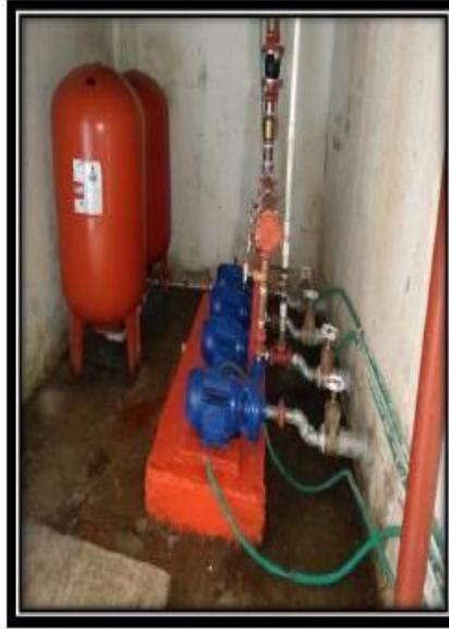
4. Se realizó, en las líneas de Succión, la instalación de Nipleria en acero inoxidable con válvulas de pie para cada bomba, con registros de corte.
