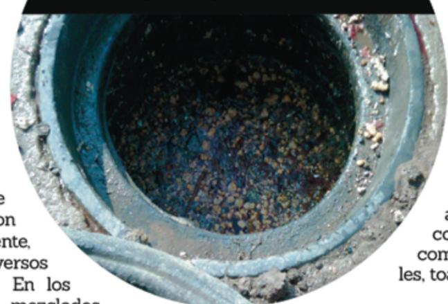
· Las descargas no domésticas conectadas al drenaje sanitario deben cumplir con las condiciones particulares de descarga; en caso de exceso de grasa, **instalar trampas** para sólidos y grasas.
