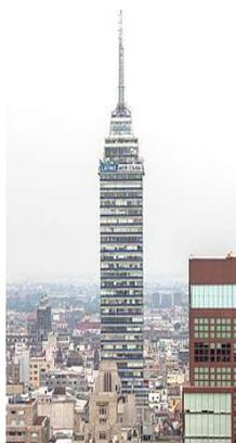
La **Torre** se afianza mediante 361 pilotes de concreto en una capa de material sólido que los estudios de resonancia ubicaron a 33 m de profundidad. Se colocó una cimentación de concreto que permite que el edificio, literalmente "flote" en el subsuelo, independientemente del soporte que le proporcionan los pilotes. Esta tecnología, original de México, fue la primera de su tipo en el mundo y sigue siendo utilizada por todos los constructores de rascacielos para zonas de alto riesgo sísmico.
