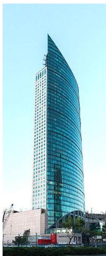
**La Torre Mayor** fue el primer rascacielos en el mundo en contar con amortiguadores sísmicos, cuenta con 98 amortiguadores que liberan silicio para disipar la energía devastadora de un terremoto.
