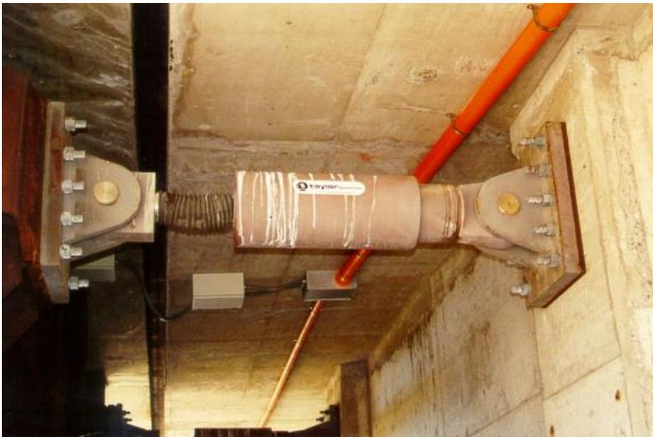
**Disipador Viscoso de Energía**
