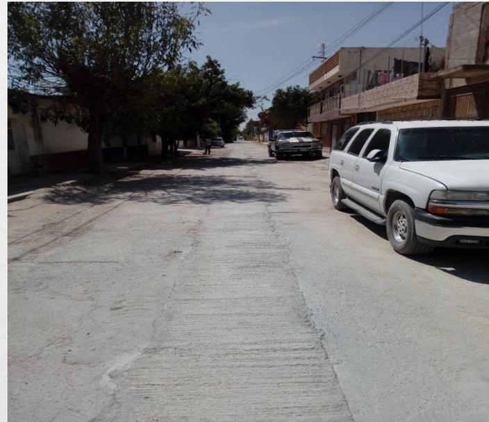
**“REHABILITACIÓN DE RED DE ALCANTARILLADO SANITARIO EN CALLE RÉGULES (5 DE MAYO A PASEO ÁNGEL VERAL), 397.93 m CON TUBO PVC SANITARIO SERIE 20 DE 305MM DE DIÁMETRO, SUSTITUCIÓN DE 67 DESCARGAS Y CONSTRUCCIÓN DE 6 POZOS DE VISITA”**
