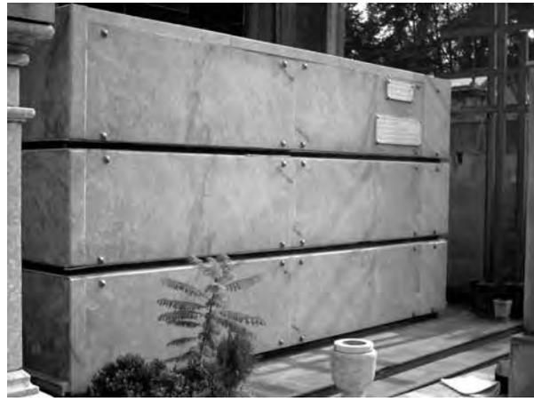
Figura 17. Construcción vertical para gavetas y nichos.
