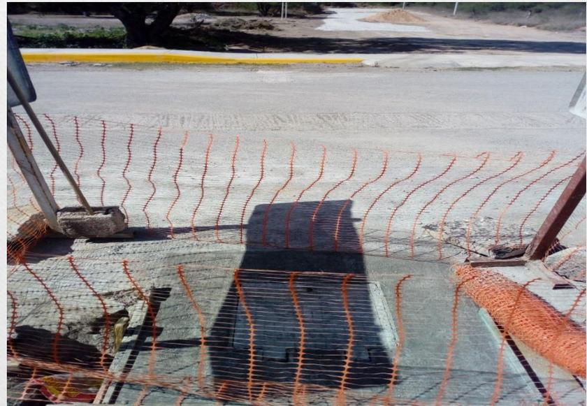
**“CONSTRUCCIÓN DE RED DE ALCANTARILLADO SANITARIO EN CALLE NEFI, COL. LA FLORIDA (141.23 M CON TUBERÍA DE PVC SANTARIO PARED COMPACTA SERIE 20 DE 250MMY 2 POZOS DE VISITA)”**
