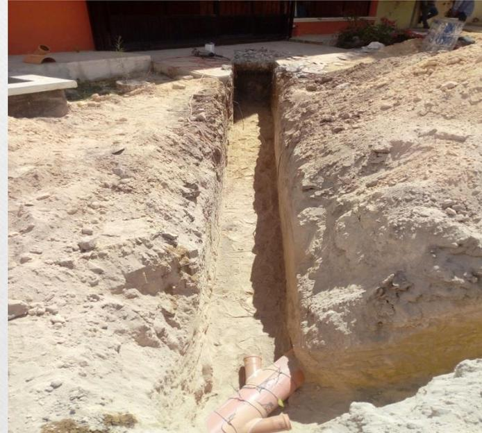
**“CONSTRUCCIÓN DE RED DE ALCANTARILLADO SANITARIO CALLE PINABETE, COL. LA FLORIDA (142.00 M CONTUBO PVC SANITARIO DE PARED COMPACTA SERIE 20 DE 250MMY 2 POZOS DE VISITA)Y CONSTRUCCION DE RED DE ALCANTARILLADO SANITARIO EN LA CALLE PINOS, COL. LA FLORIDA (142.00 M CONTUBO PVC SANITARIO DE PARED COMPACTA SERIE 20 DE 250MMY 2 POZOS DE VISITA)”**
