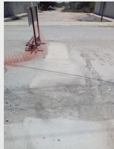
**“CONSTRUCCIÓN DE RED DE ALCANTARILLADO SANITARIO EN PRIVADAS RIOVERDE, MOCTEZUMA Y XILITLA EN EL FRAC. ANIMAS (815.6 M CON TUBERÍA DE PVC SANITARIO DE PARED COMPACTA SERIE 20 DE 250MM Y 18 POZOS DE VISITA)”**
