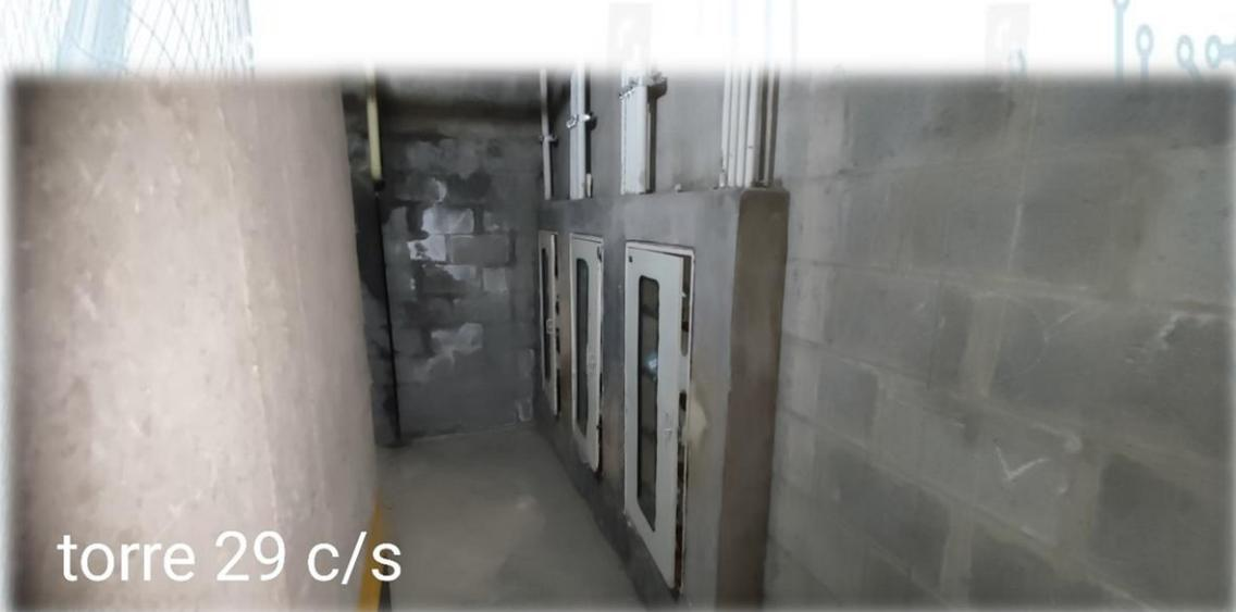
En esta torre se necesitan intervenir los 3 gabinetes incluyendo flautas con su respectivo registro y cambio de tubería en estrada y salida a medidores. los otros 3 gabinetes no entran en garantía y solo tienen cambio de flauta y registros, las salidas de medidores no se cambiaron. (no se encuentra un registro y no cumple con trazabilidad de componentes la cual no se puede generar garantía).
