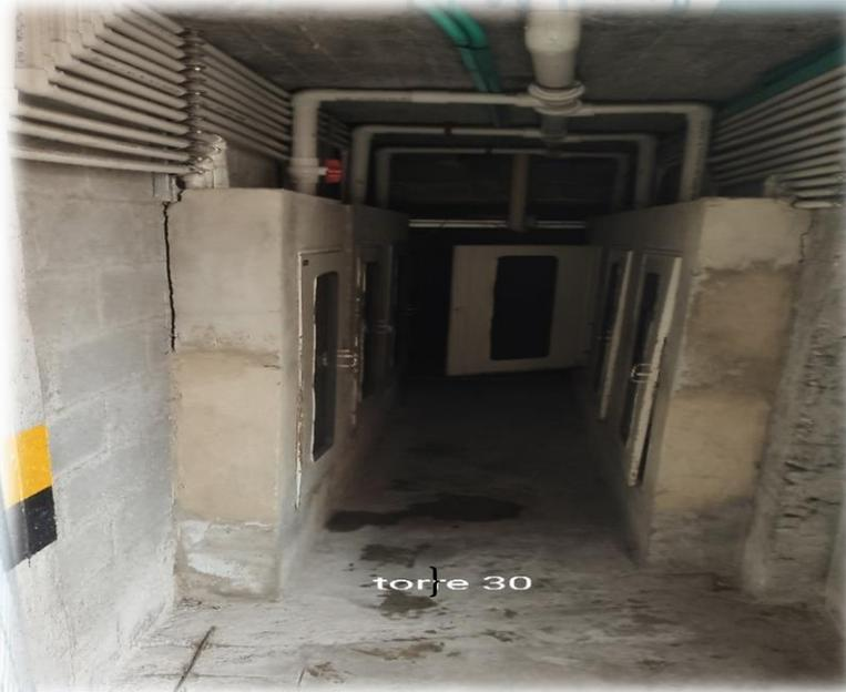
En esta torre se necesitan intervenir los 5 gabinetes incluyendo flautas con su respectivo registro y cambio de tubería en estrada y salida a medidores. Se encuentra un gabinete terminado y hay solo un registro en un gabinete con flauta pero este no tiene cambio en la tubería de salida por lo tanto este gabinete (no se encuentra un registro y no cumple con trazabilidad de componentes la cual no se puede generar garantía).
