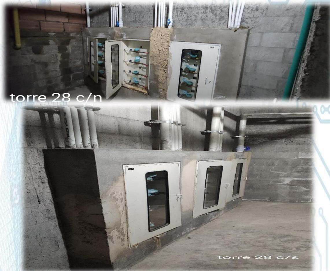
En esta torre se necesitan intervenir los 5 gabinetes incluyendo flautas con su respectivo registro y cambio de tubería en estrada y salida a medidores. Se encuentra un gabinete terminado y hay solo dos registros dos gabinetes con flautas pero estos no tienen cambio en la tubería de salida por lo tanto estos gabinetes (no
