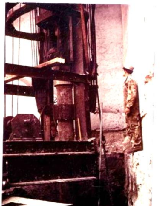
Camisa de tubo corrugado de cada pilote
