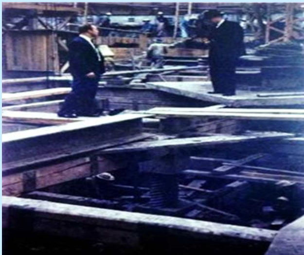
Hileras de Pilotes de Apoyo al Contraventeo
