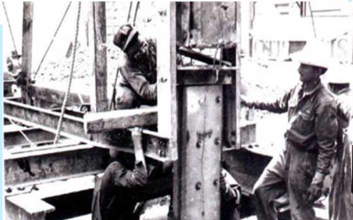
Ataguías machimbradas de la cimentación
