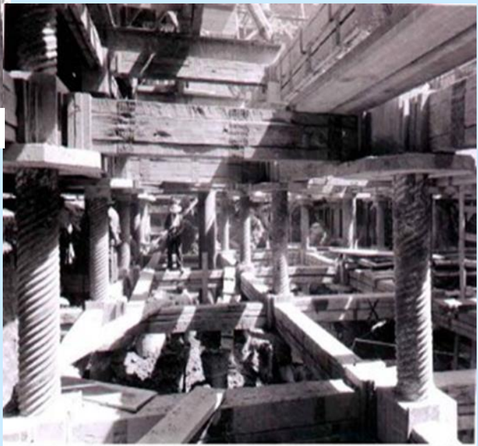
Hileras de pilotes de apoyo al contraventeo
