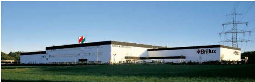
Planta industrial en Unna - Alemania
