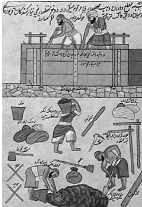
Figura 6. Albañiles construyendo una tapia. J. Agustín Núñez y Aurelio Cid Acedo, La Alhambra de cerca , Granada, Edilux (Guía visual de la visita a la Alhambra y Generalife), 1992, p. 51. Dibujo de la India musulmana mostrando la construcción del Tapial .
