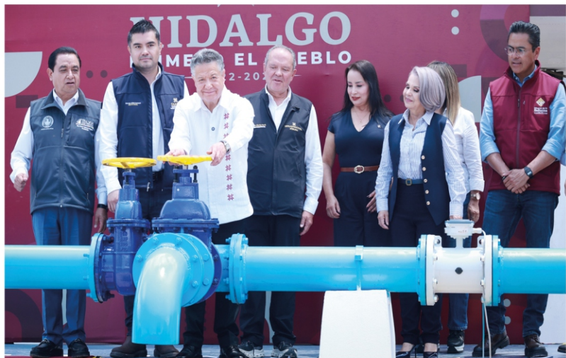
El gobernador Julio Menchaca, acompañado de funcionarios estatales, dio a conocer los avances en obras hidráulicas que fortalecen el suministro de agua potable.
