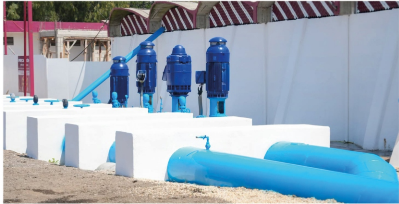
Nuevo pozo fortalece el suministro de agua potable beneficiando a habitantes de la Zona Metropolitana de Pachuca.
