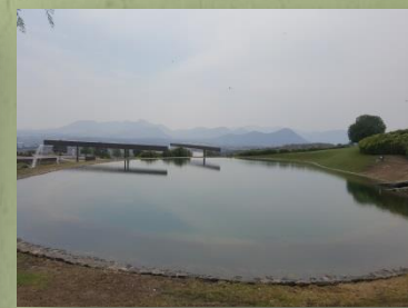
Fig. 1c: Lagos funcionando adecuadamente en Mayo de 2017, 9 años después de entregada la instalación.
