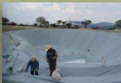
Fig. 1b: Membrana GEOVIN® instalada; se suministraron paneles prefabricados que posteriormente se unieron por termofusión en el sitio.
