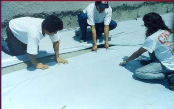
GEOVIN® se instala sobre la losa de techo y posteriormente se coloca material permeable, para drenaje de excedentes de agua y la tierra vegetal. Una solución más económica y segura, que reduce el peso sobre la losa, es la sustitución de los rellenos de grava, por drenes sintéticos prefabricados, que pesan tan sólo una pequeña fracción de los materiales pétreos y drenan la misma cantidad de agua en menos de 1 cm de espesor.
