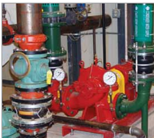
Instalación 'verde' de alto rendimiento
