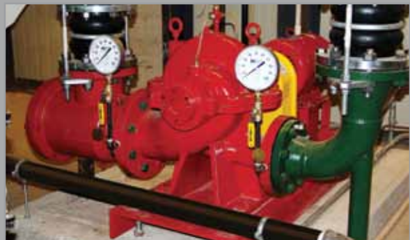
East Hartford High School —las bombas horizontales de carcasa dividida EnviroFlo cumplieron con exigencias críticas de plazos de construcción gracias a su fácil instalación en la base, que no requiere lechada. Ahora están proporcionando circulación de alto rendimiento de agua refrigerada y agua de condensado primaria/secundaria, para un confiable confort de estudiantes y profesores.
