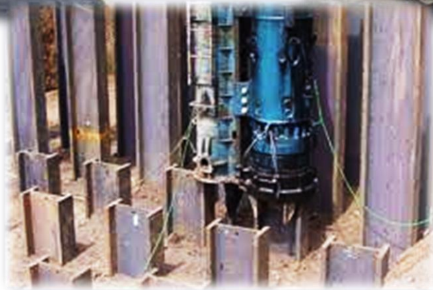
Pilotes de Tubo cerrados con punta
