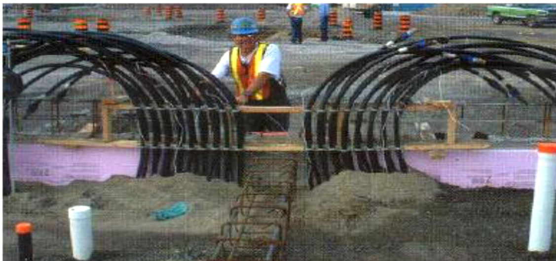
Ductos para circulación de agua dentro de cimentaciones térmicas
