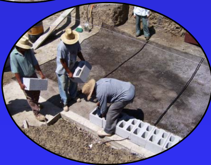
Colocación de bloques y refuerzos
