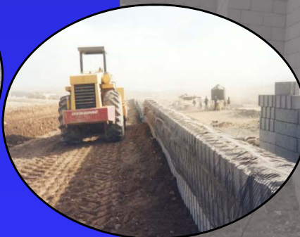
Colocación y compactación del relleno
