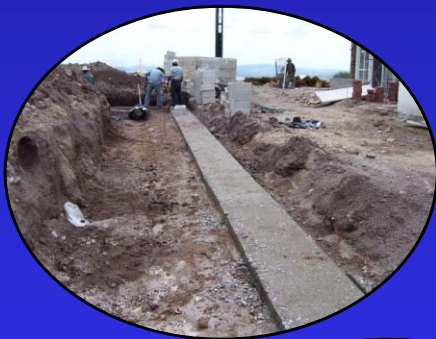
Colado de plantilla de desplante
