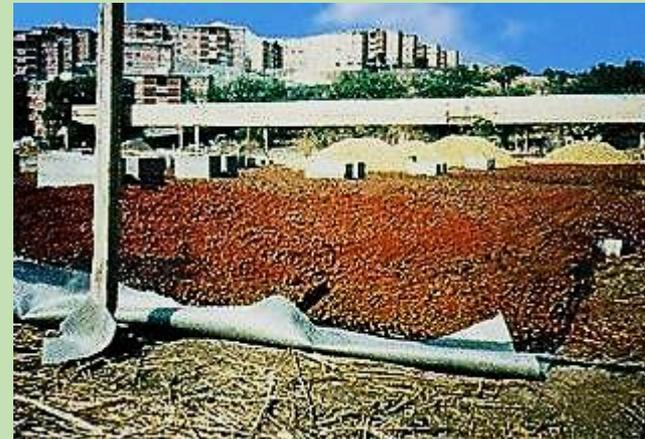
*Colocación de material granular sobre PAVITEX® y TERRA-TEC*
