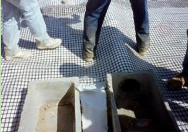
*Donde fue necesario, se efectuaron cortes en PAVITEX® y TERRA-TEC, para acomodar los drenajes.*
