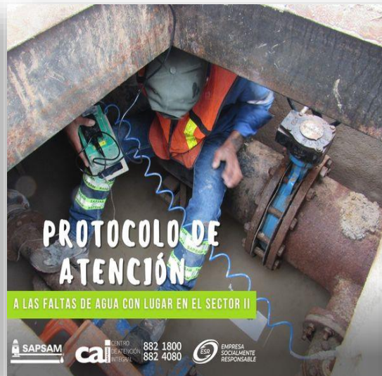
Toma de lecturas y limpieza de filtro en cajas especiales
