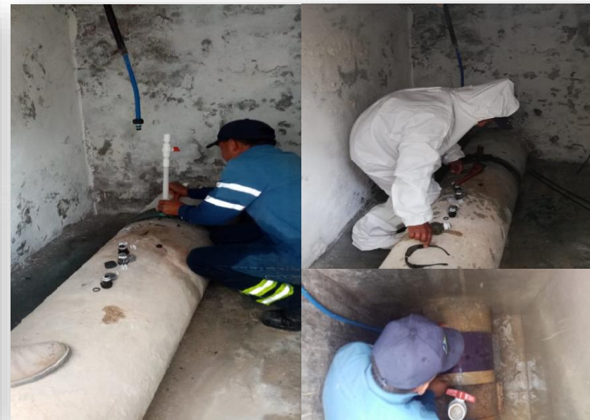
Colocación de abrazadera en conexión de línea de cloración con línea de conducción de asbesto por fin de vida
