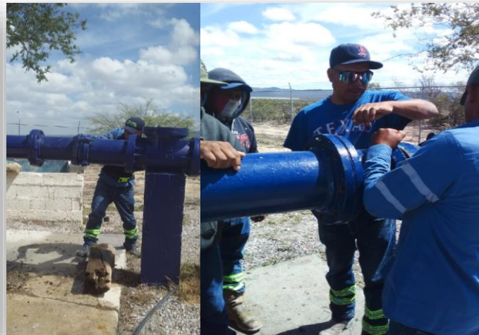
Cambio de empaques a junta en tren de descarga en Pozo 17
