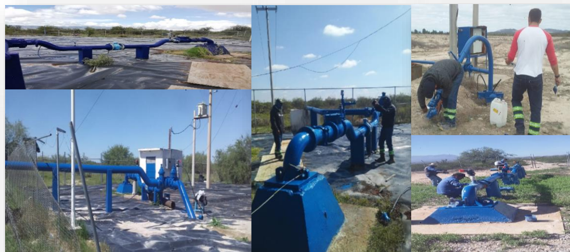
Pintura en tren de descarga de los pozos
