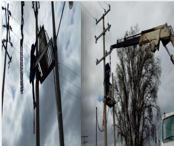
Intercambio de transformador del Pozo 19 al Pozo 20
