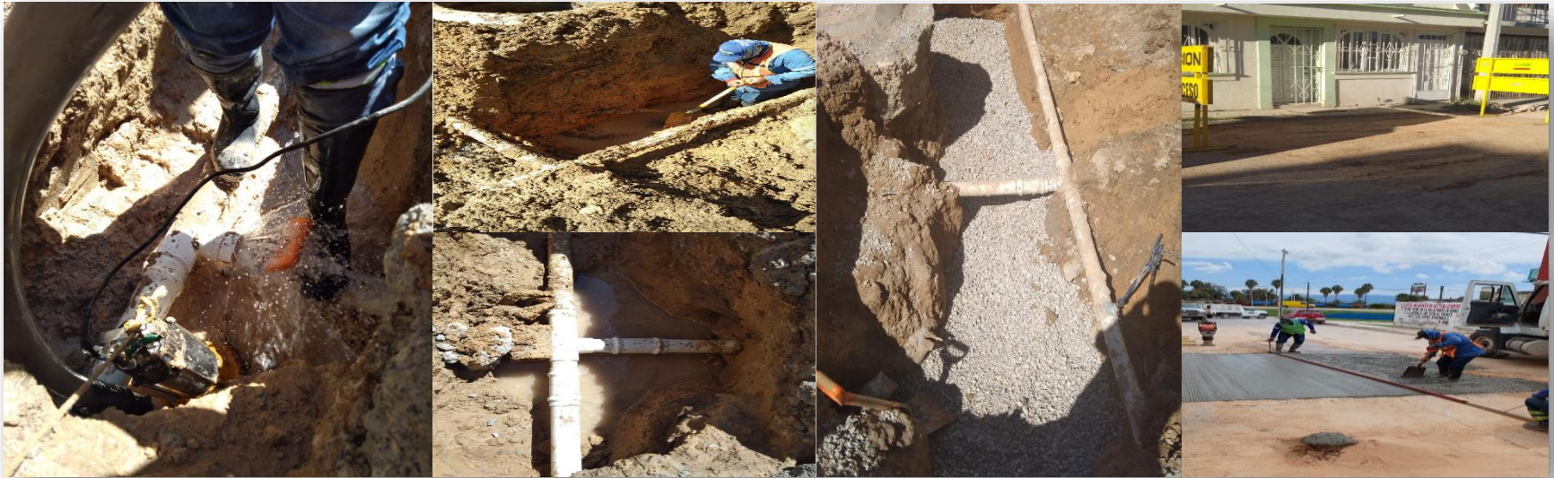
Fuga en red general, Bélgica con Andador Croacia, col. Las Mercedes, fuga en tee de 3", se sustituye
