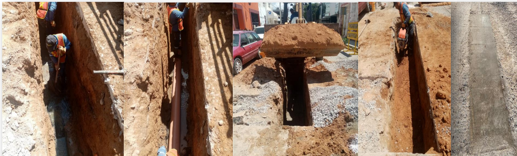
Rehabilitación de la red de drenaje, cambiando 5 mts de tubería de pvc sanitario de 10" en la calle Ocampo entre Escobedo y Juárez
