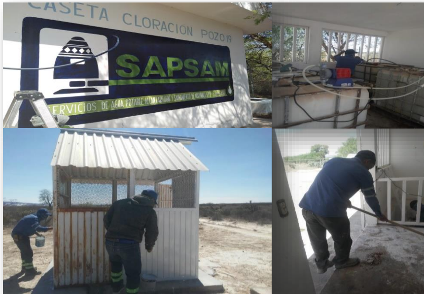
Limpezas y mantenimientos a caseta de cloración en pozo 19
