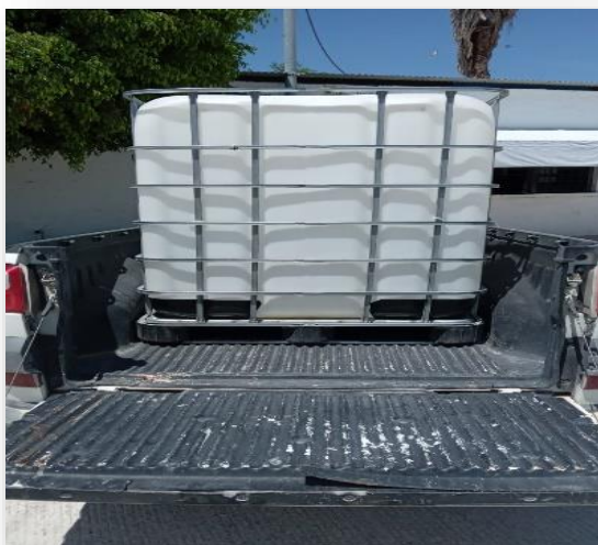
Cambio de contenedores por fin de vida en caseta de cloración
