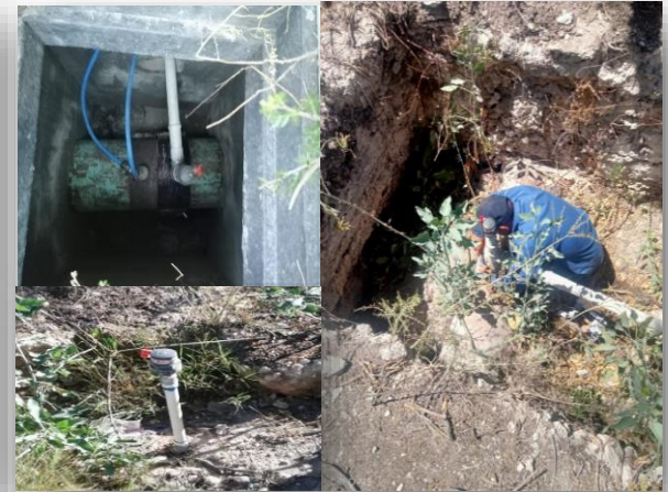
Instalación de válvulas expulsoras de aire en diferentes puntos
