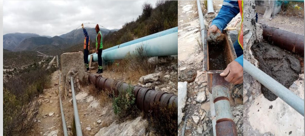
Mantenimiento y reparación de fuga en ducto tramo San Bartolo
