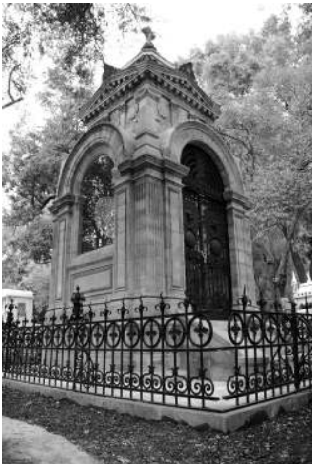
Figura 56. La capilla de Matías Romero recién restaurada; como una primera etapa se consolidó y se limpió la cantería, se cambiaron algunas piezas, se hicieron algunos remoldeos y se le aplicó hidrofugante. Se limpió, pintó y completó la reja y se limpiaron, arreglaron y pintaron las puertas. En las ventanas se colocaron vidrios transparentes y policarbonato en las contrapuestas. Fotografías de Ethel Herrera Moreno, archivo personal.
