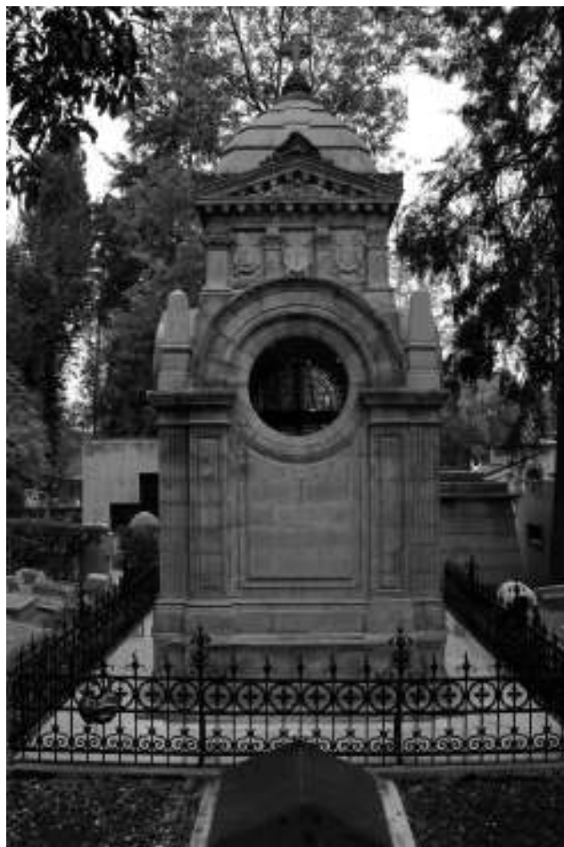
Figura 56. La capilla de Matías Romero recién restaurada; como una primera etapa se consolidó y se limpió la cantería, se cambiaron algunas piezas, se hicieron algunos remoldeos y se le aplicó hidrofugante. Se limpió, pintó y completó la reja y se limpiaron, arreglaron y pintaron las puertas. En las ventanas se colocaron vidrios transparentes y policarbonato en las contrapuestas. Fotografías de Ethel Herrera Moreno, archivo personal.
