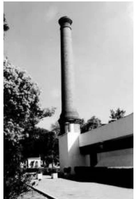
Figura 16. Nueva construcción que alberga los hornos crematorios y la capilla. Fotografía de Eitel Herrera Moreno, archivo personal.
