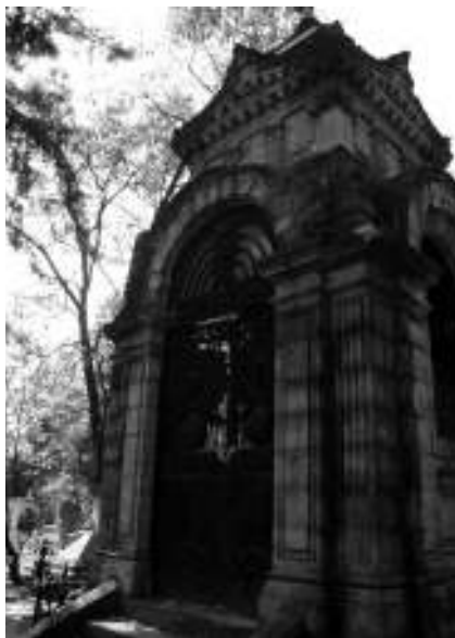
Figura 55. La capilla de Matías Romero a principios del siglo XXI: sin vitrales ni coronas, sin remates ni partes de barandal, y sumamente deteriorada. Fotografías de Carlos Segura Martínez.
