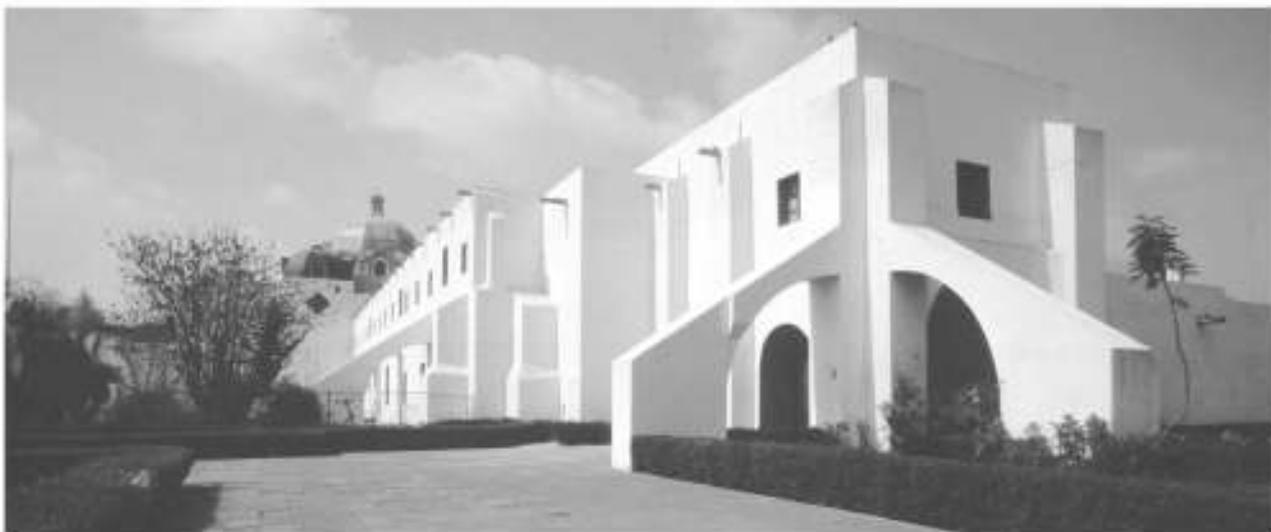
Figura 5. Arbotantes en la parte posterior oriental del convento, edificadas en virtud de la alta sismicidad de la zona.
