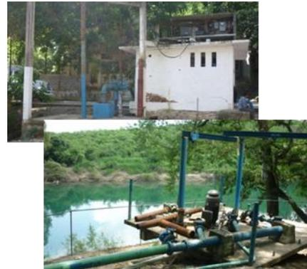
Se opera con 2 líneas de aducción e interconexión de tanques con tubería de acero de 6 y 8 pulgadas de diámetro con una longitud de 1.1 kilómetros y una red de distribución de 32.1 Kilómetros de longitud, de la cual 7.1 Kilómetros es red primaria y 25 Kilómetros red secundaria y terciaria en asbesto, acero y pvc.
