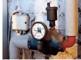
Manómetro conectado a una tubería.
