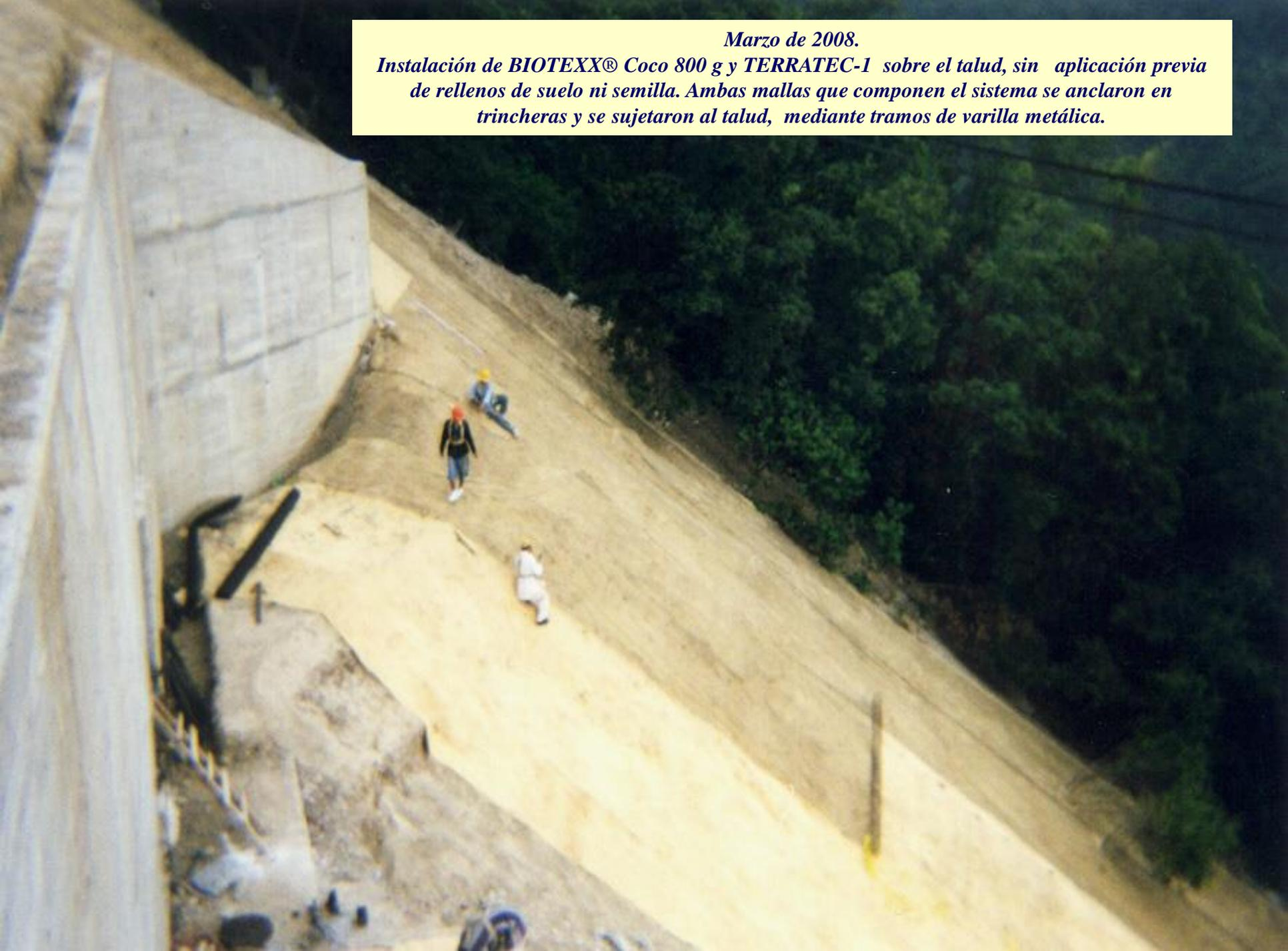
*Obsérvese la cantidad y tamaño del material rocoso que se requería estabilizar, mismo que se cubrió con ambas mallas que componen el sistema mixto. No se removió material superficial de ningún tipo antes de aplicar los productos.*
