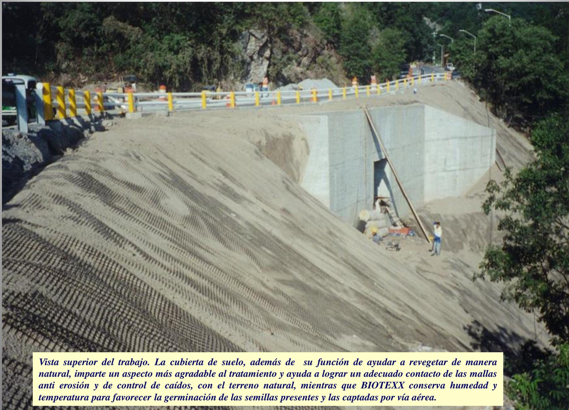
*Vista superior del trabajo. La cubierta de suelo, además de su función de ayudar a revegetar de manera natural, imparte un aspecto más agradable al tratamiento y ayuda a lograr un adecuado contacto de las mallas anti erosión y de control de caídos, con el terreno natural, mientras que BIOTEXX conserva humedad y temperatura para favorecer la germinación de las semillas presentes y las captadas por vía aérea.*
