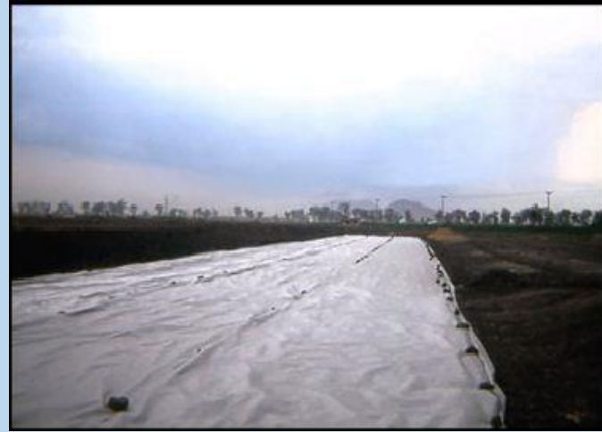
Colocación de material ligero (tezontle) y sobre él, PAVITEX® 350
