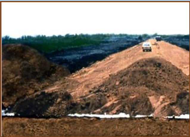
Colocación de la capa subrasante y el pavimento
