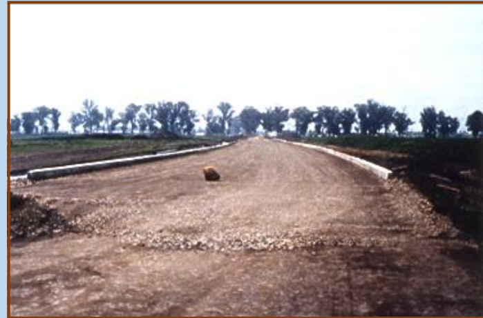
Colocación de la capa subrasante y el pavimento
