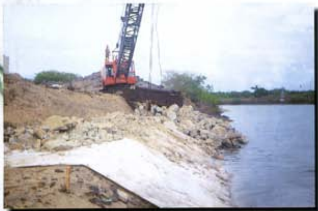
Reconstrucción de un muelle particular en Nuevo Vallarta, Jal., empleando PAVITEX® debajo de un enrocamiento. 1984.
