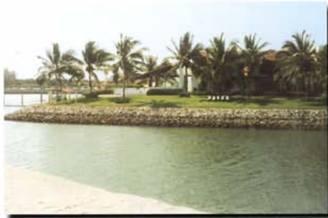
Aspecto de la protección en perfectas condiciones en marzo de 1996, 12 años después de terminada.
