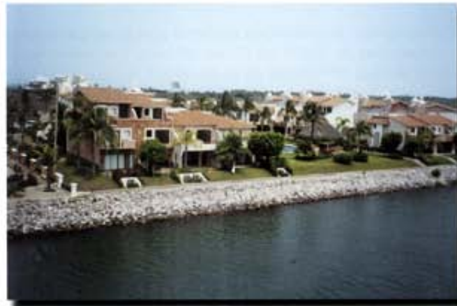
Aspecto de la protección en el año 2000, al cabo de 7 años de la instalación de PAVITEX®.
