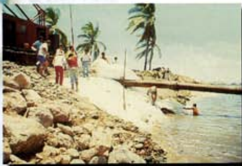
PAVITEX ® se adapta al terreno sin romperse, aunque éste no se haya afinado, debido a su alta capacidad de elongación.
