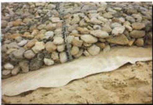
El filtro PAVITEX ® evita la socavación de suelos a través de agregados gruesos, pero permite la liberación de la presión hidrostática
