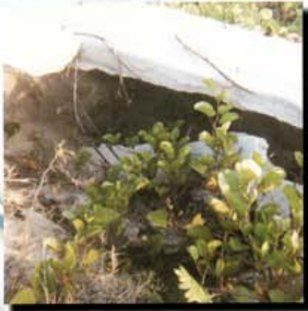
Socavación de un muelle por cambios de marea.
