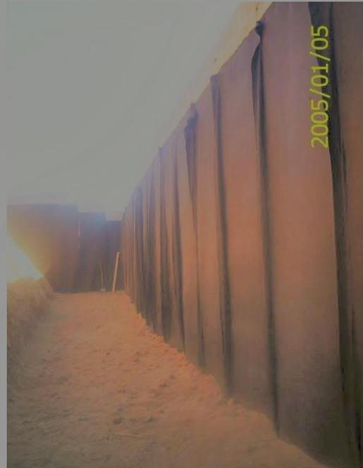
PAVIDREN® "C" se coloca en el respaldo del muro, se conecta a la tubería de descarga, y posteriormente se rellena.
