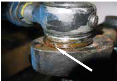
Cubre Polvo Dañado de la Terminal.
