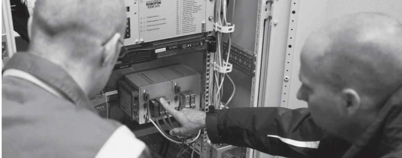
cableado. Es preciso escoger bien los cables y determinar el trazado apropiado en la planta. Con la elección de un buen trazado para los cables, por ejemplo, evitando fuentes potenciales de interferencia electromagnética, utilizando bandejas metálicas y separando los cables de alimentación y de bus en la bandeja portacables, se contribuye significativamente al buen funcionamiento del bus. Nota: no utilice nunca cables Profibus DP para conectar equipos PA, ni viceversa.
