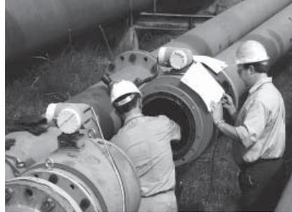
Inspección de la tubería del caudalímetro
