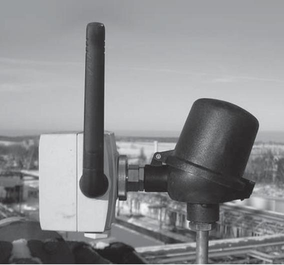
WirelessHART es el estándar de HART Communication Foundation para comunicaciones sin cable en la automatización de procesos. Este estándar agrega la capacidad de funcionamiento sin cables al protocolo HART, a la vez que mantiene la compatibilidad con los equipos, comandos y herramientas HART ya existentes.
