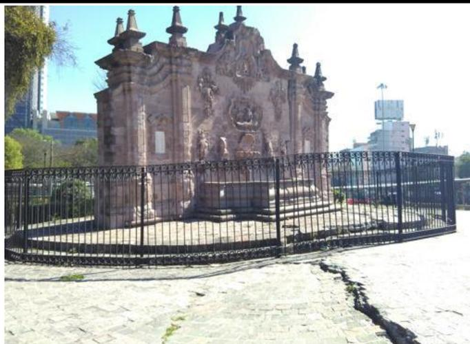
Grietas en el suelo por el hundimiento del terreno- A. ESPALLARGAS
