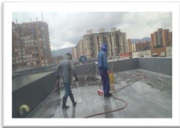
**Mantenimiento de cubiertas:** Se realizo el mantenimiento de las cubiertas para impedir filtraciones, humedades, mal aislamiento y así mantener la conservación de manera periódica evitará el tener que afrontar reparaciones mayores a largo plazo.
