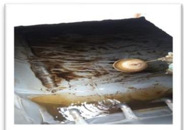
**Cajas de aguas negras:** Se realizó la limpieza y mantenimiento de las cajas de aguas negras correspondiente a la zona de parqueaderos, en virtud del mal uso de los desagües por parte de los residentes que arrojan desechos que tapan estos ductos afectando a los primeros pisos.
