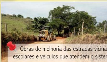
Obras de melhoria das estradas vicinais, com limpeza, abertura e cascalhamento, por onde trafegam os ônibus escolares e veículos que atendem o sistema municipal de saúde.
